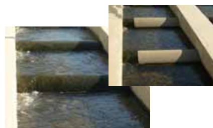
写真－7 全越流（切欠）タイプの例
