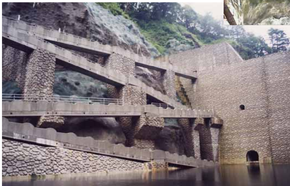
階段状に配置した PC桁上に設置
