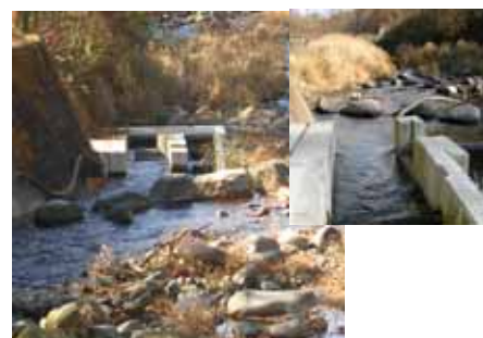
写真－５ 置石により転石対策した事例
