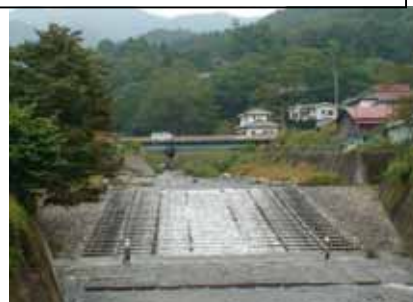
写真－１ 全断面魚道の事例
