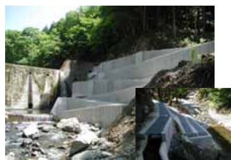
写真－４ 堰堤袖部に設置した事例
